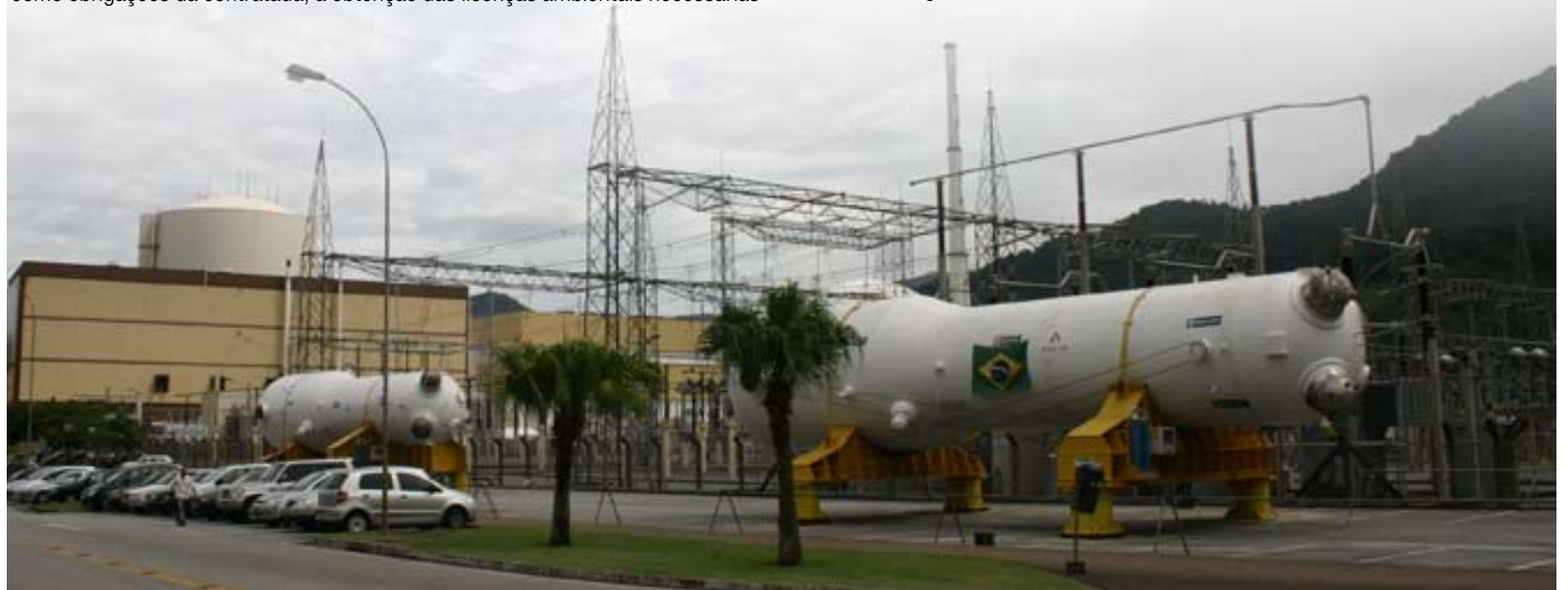
Novos Geradores de Vapor de Angra 1
