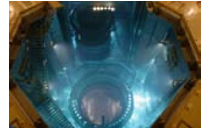
Núcleo do Reator durante parada de manutenção e reabastecimento de combustível
