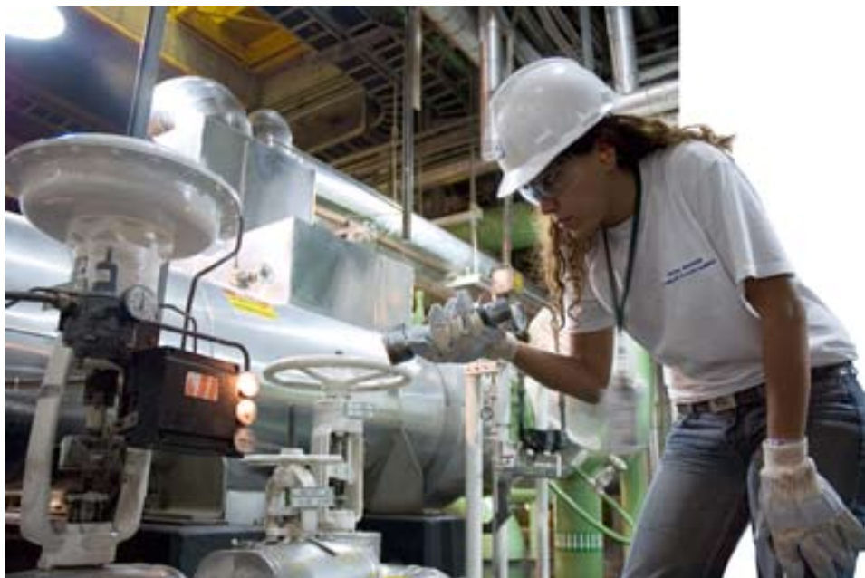
Técnica inspeciona válvula no edifício da turbina de Angra 1
