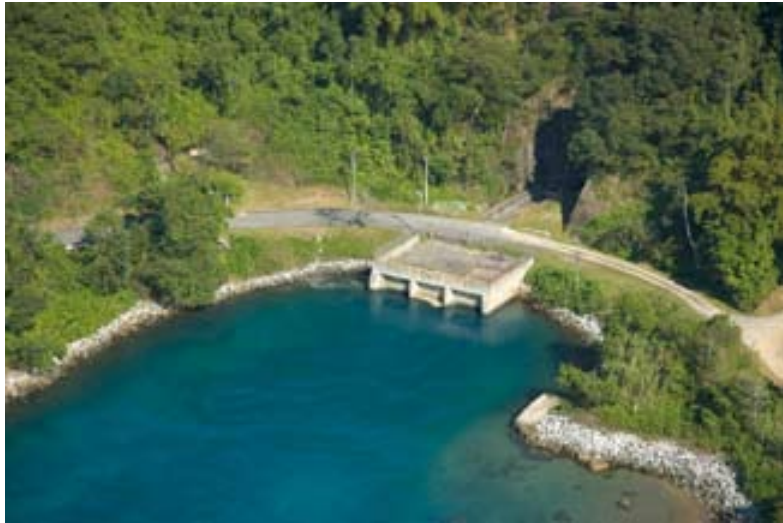
Saída da água de refrigeração dos condensadores principais de Angra 1 e Angra 2 - Saco da Piraquara de Fora
