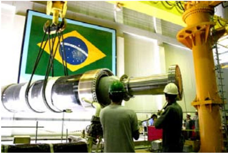
Operação da troca do rotor do gerador elétrico de Angra 2
