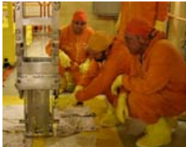
Profissionais trabalhando no reparo de Elementos Combustíveis de Angra 2
